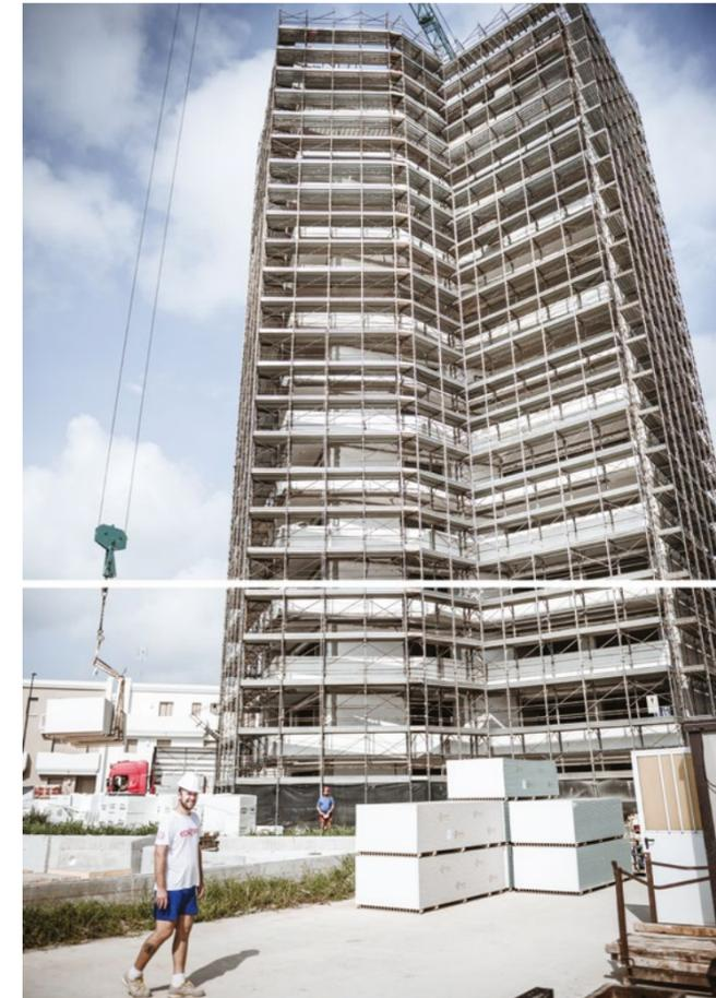
In fase di costruzione, al guscio di cemento armato è stato applicato un consistente isolamento termico e una facciata in alluminio con sottostruttura metallica.
