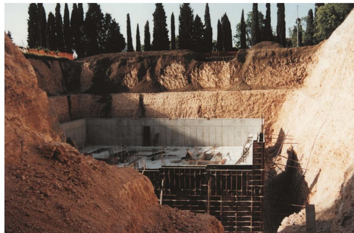
Per le strutture sono stati utilizzati pilastri multipiano di tipo misto in acciaio e cemento, solai di tipo alveolare precompresso autoportante, travi prefabbricate reticolari autoportanti tipo REP e muri perimetrali gettati in opera.
