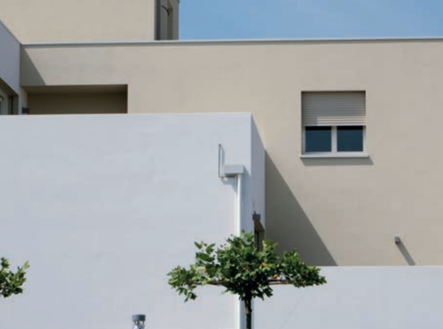
GLI ATTICI Piove di Sacco, Padova Complesso residenziale
